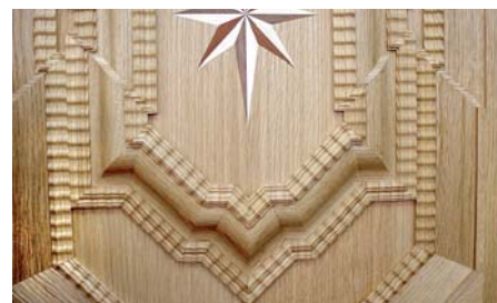
Flammleisten an einer Türfüllung
