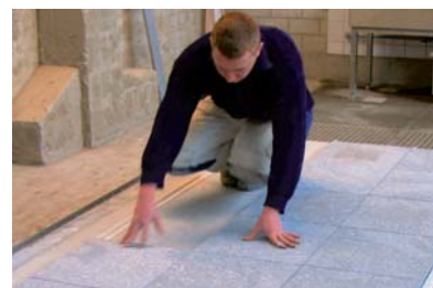
Belegen einer Bodenfläche
