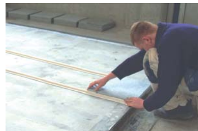
Verlegen der Trägerschienen
